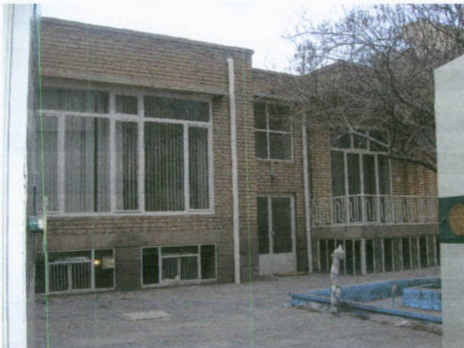
۲_ تصویر ، قسمتی از نمای ضلع غربی بنا را نشان می دهد .
